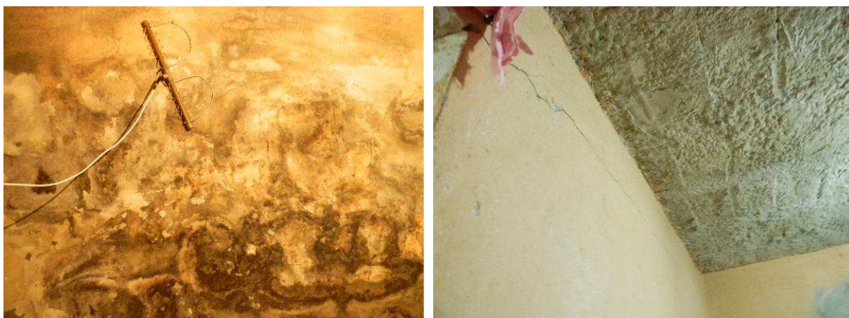
Figura 78: Infiltrações e rachaduras numa das unidades da Vila Zé Botinha.
