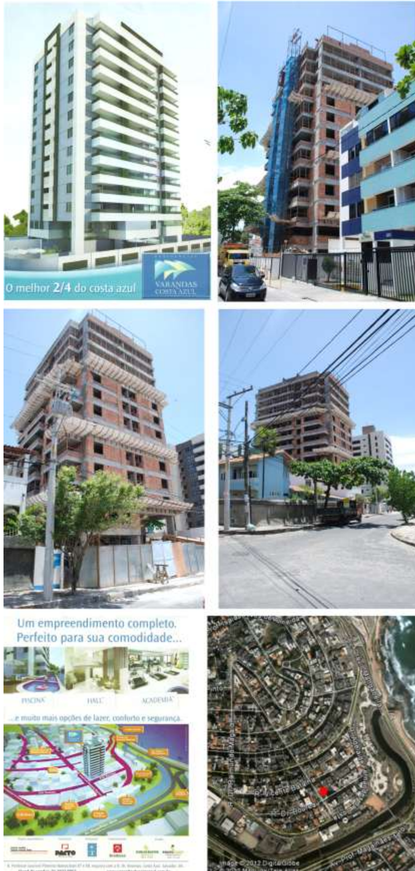
Figura 3 - Empreendimento: Varandas do Costa Azul. Bairro: Costa Azul. Acima, imagens do panfleto; abaixo, fotografias do local em nov/2011 e mapa da ocupação atual da área de implantação, no qual a marca em vermelho indica o local da construção (mapa do Google Earth, 2012).
