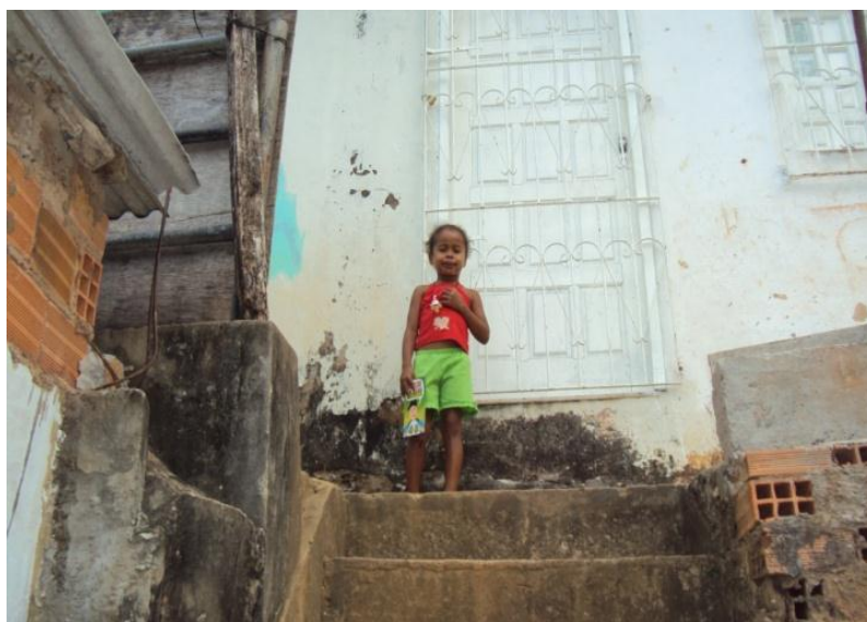
Foto 1 - Escada que leva ao corredor da casa.
