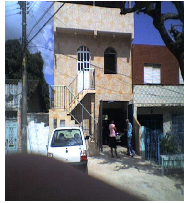
Entrada do Sinditêxtil.
