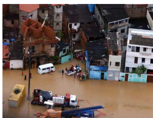
Figura 37. Alagamento em via pública
