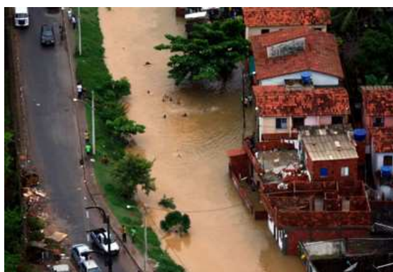
Figura 36. Casas do bairro inundadas
