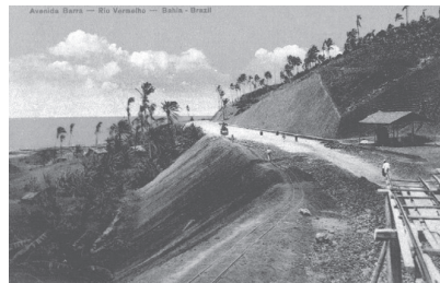
29. Avenida Oceânica – obra
