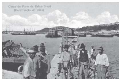
36. Obras do porto - equipamentos pesados, trabalhadores
