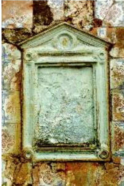
Figura 15: HOLTHER, J. (Sem título). 1998. 1 fot., color. 10cm x 15 cm. Foto do nicho (preenchido com argamassa) existente na fachada principal do sobrado conhecido por “Casa das Sete Mortes”, situado na Rua Ribeiro dos Santos, número 24, bairro de Santo Antônio.
