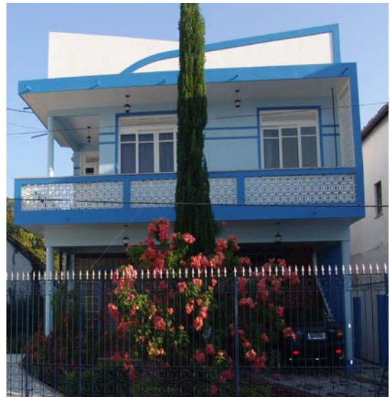
Fig. 27 - Atual fachada de Nova Brasília Foto de Marcos Antônio Pereira - 2007
