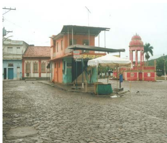
Fig. 40 - Pç. Emerzindo Mendes, após recentes reformas - Foto de Aline Farias - 2008
