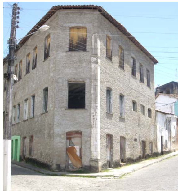
Fig. 42 – Sobrado da Rua Fernando Suerdieck, após recentes reformas. Foto de Aline Farias – 2008.
