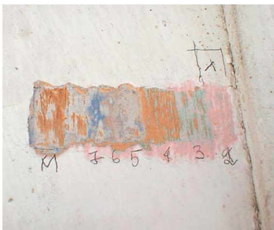
Figura 97: Exemplo de prospecção realizada em parede de madeira. Foto: Natália Naoumova.
