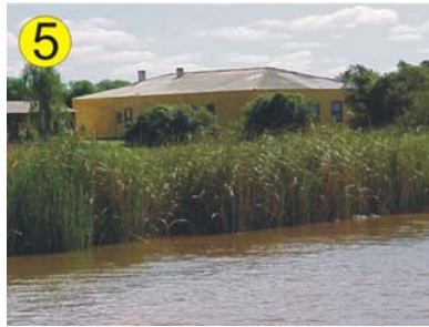
Figura 61: Sede da charqueada do Barão de Arroio Grande. Foto Douglas Heidtmann Jr.
