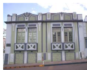
Figura 28: Pintura realizada em 1998.
