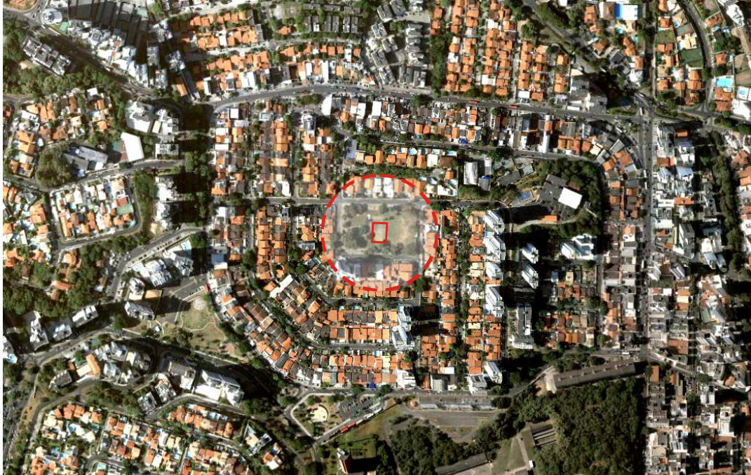
Figura 27: QE pública , localizada na Praça do Parque Residencial Nossa Senhora da Luz, bairro Itaigara, que serve aos moradores da RA Pituba que não dispõem de QEs privativas . Fonte: Google Earth 5.0 (GOOGLE, 2009)
