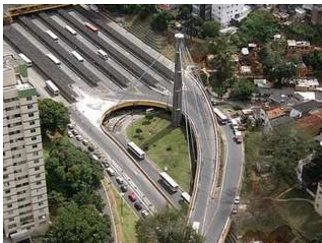
Figura 10: Vista de cima da estação da Lapa
