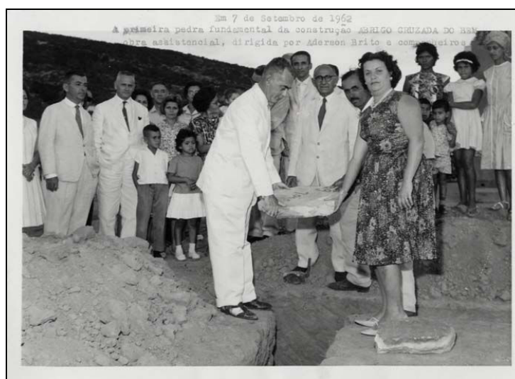
(34) Prefeito e esposa inauguram pedra fundamental da construção do Abrigo Cruzada do Bem. 1962. Foto: Osmar Micucci. Acervo particular da Família Barberino.
