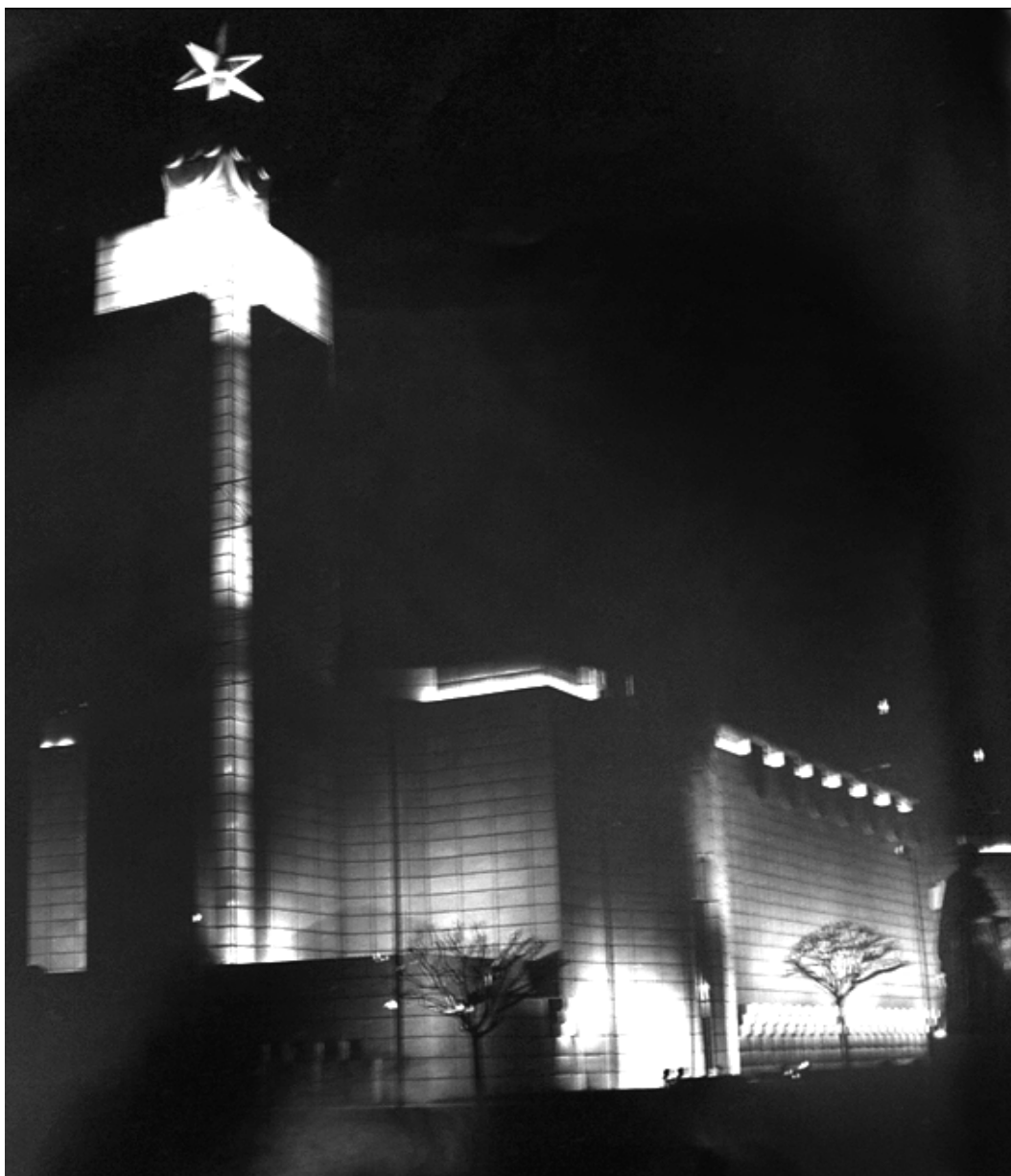
Foto 42 – Efeito luminotécnico do Pavilhão Portugueses no Mundo 192
