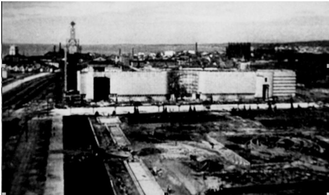
Foto 8 – Construção do Pavilhão dos Portugueses no Mundo e a Praça do Império 121
