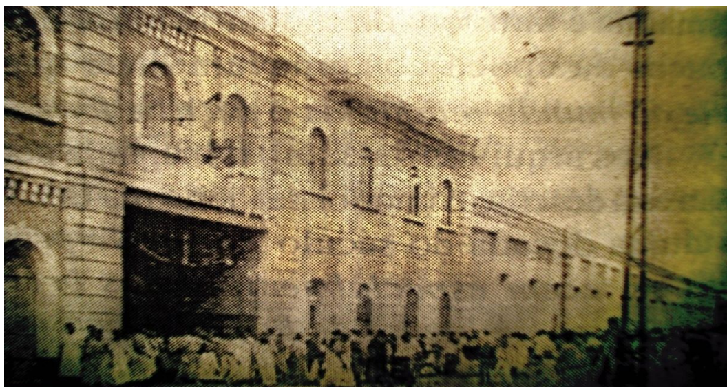
Figura 4 – Fachada principal: entrada das(os) operárias(os) Fonte: DUMÊT, 1999.
