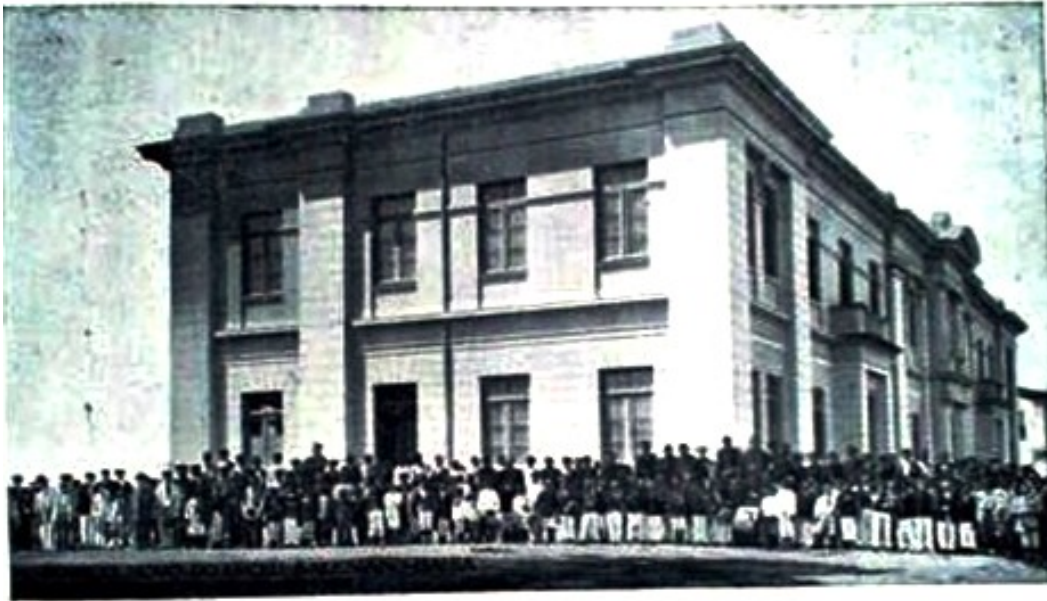
Parte lateral do edifício do Liceu Salesiano do Salvador, Bahia
