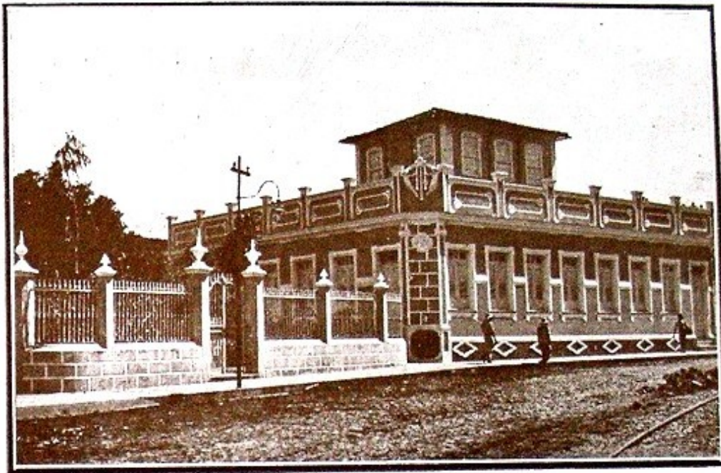
Figura 3 – Foto publicada na Revista Bahia Ilustrada, 1920: Residência do diretor da Estrada de Ferro de Nazareth.
