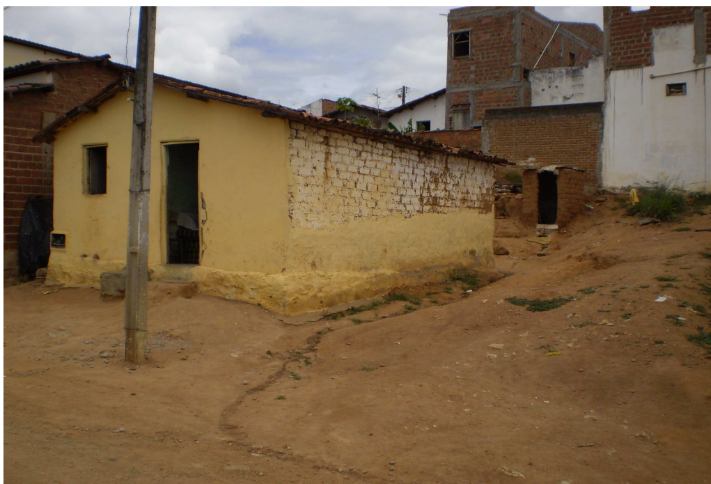
Foto 03 - Casa localizada em uma rua sem a assistência do PHB-BID Fonte: PC - 2006
