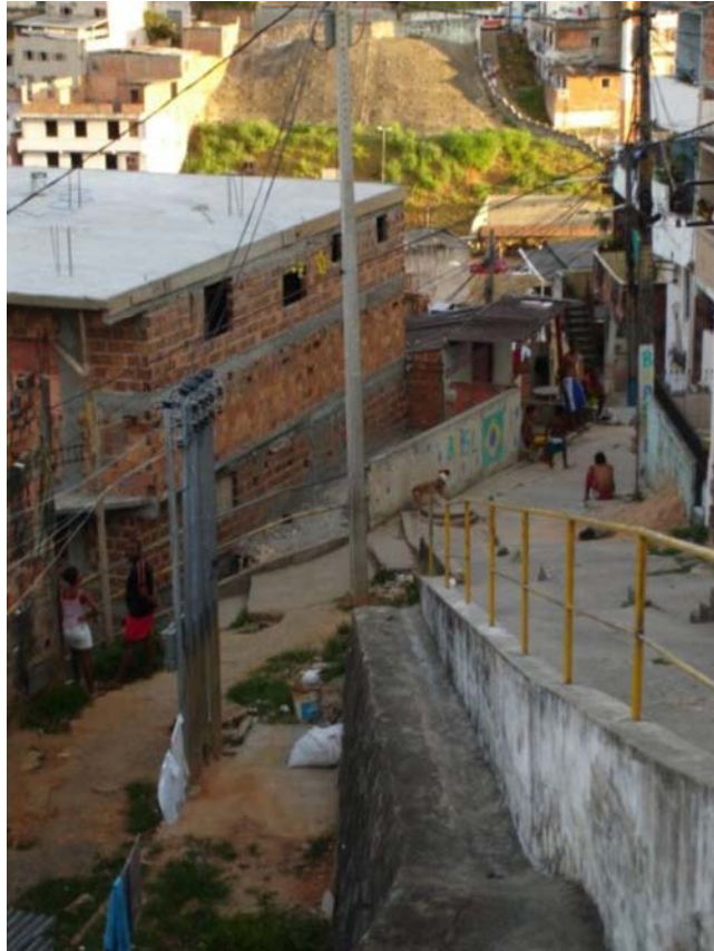
Figura 6 – Lajes, rampas e escadarias da Rua Lima Teixeira em direção à Avenida Bonocô
