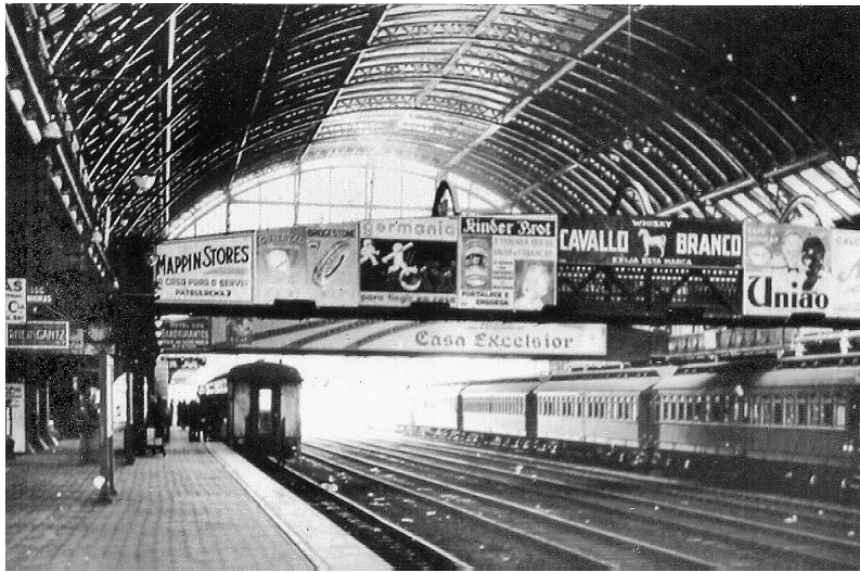
Fig. 11. Interior da Estação da Luz. São Paulo, déc. 30.
