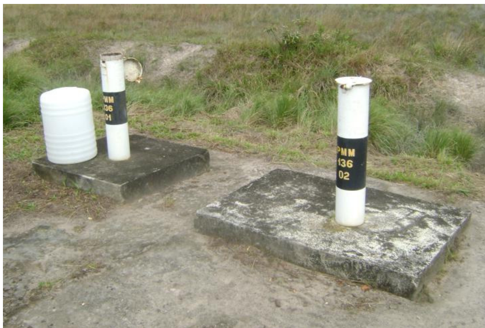
Figura 8. Ponto de coleta com dois poços de monitoramento de águas subterrâneas.
