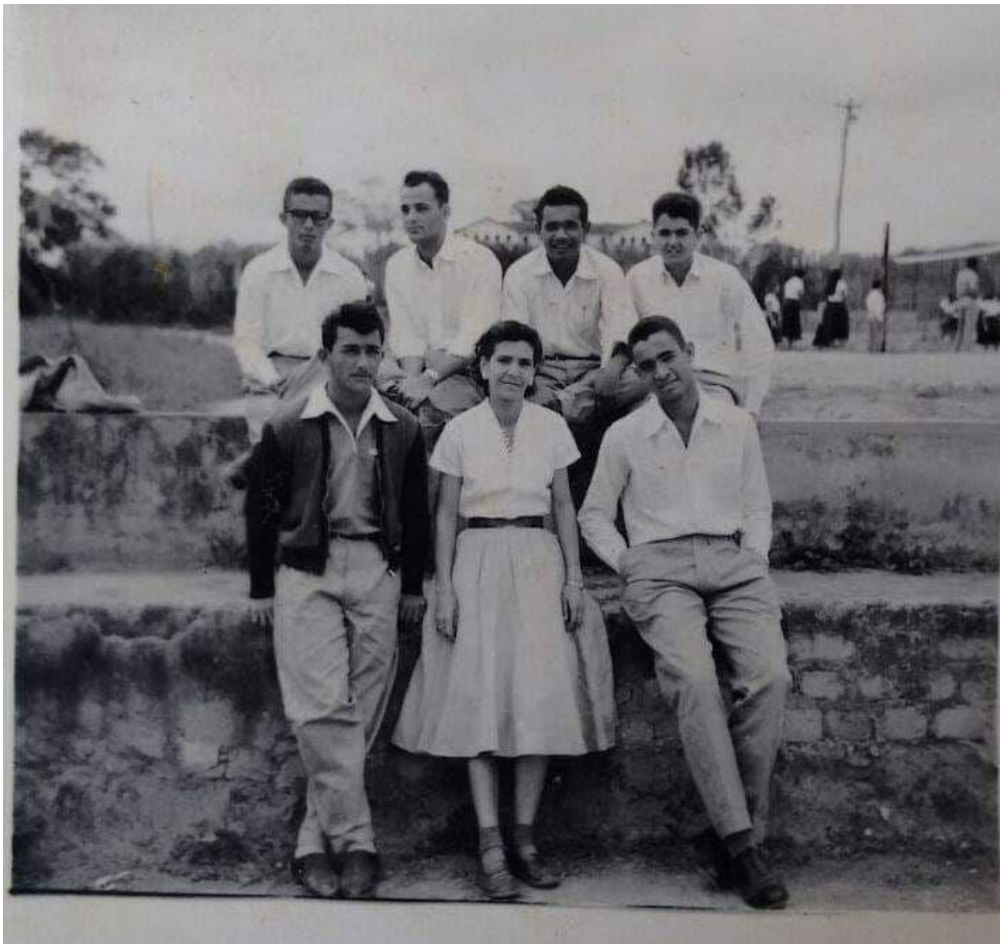
FOTO 13. Turma de Alunos do IPN Internos na Praça de Esportes em Construção (1958)
