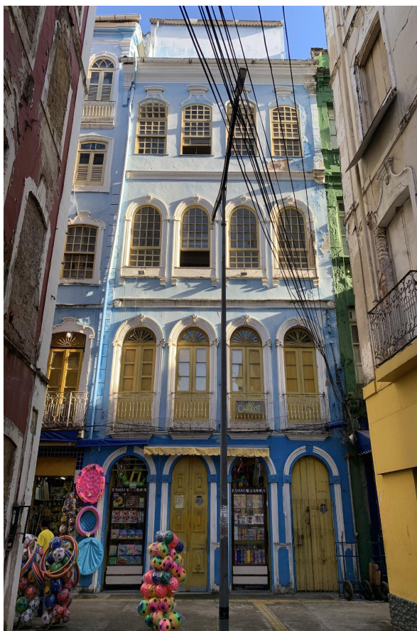
Figura 12 - Fachada da Casa Charriot no bairro Comércio
