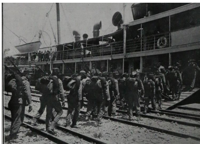
Figura 25: A intervenção na Bahia. 53º Batalhão preparando-se para embarcar no Orion. Fonte: 03/02/1912.
