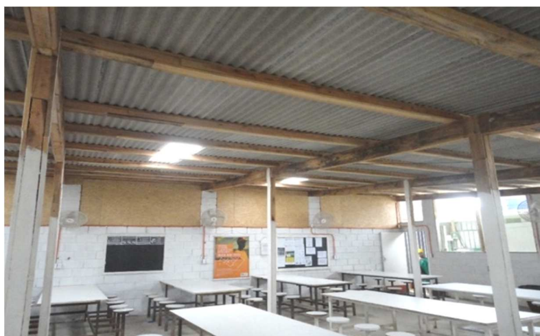
Figura 25 - Uso de iluminação natural no refeitório da obra
