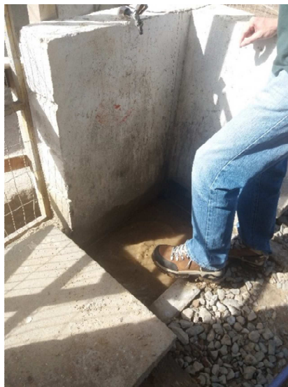
Figura 22 - Lava botas com reutilização da água usada na pia
