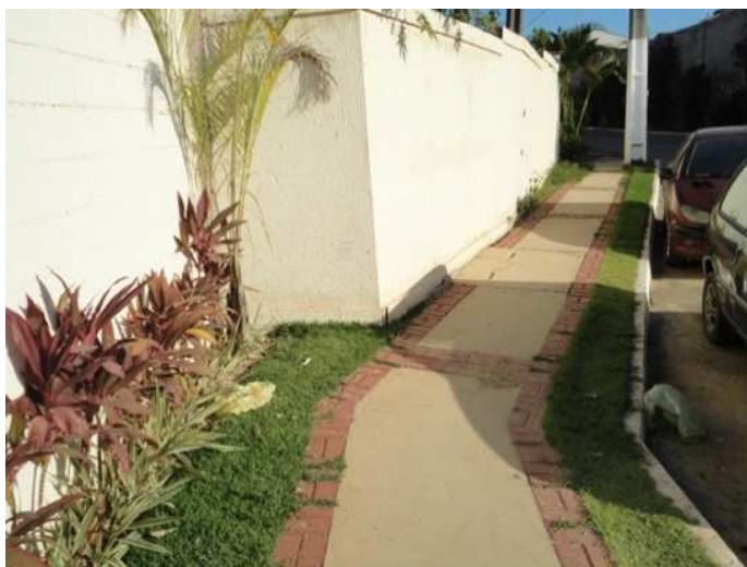
Figura 41 – Passeio da obra limpo, sem obstáculos, com jardim e muro pintado
