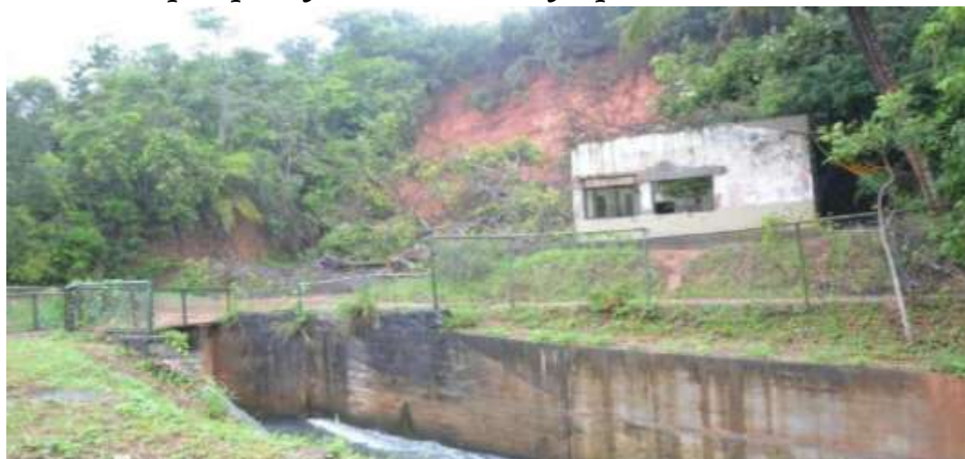
Figura 5 – Canalização do Rio das Pedras no Bate Facho, comunidade do entorno do Parque, que sofre com enchentes frequentes
