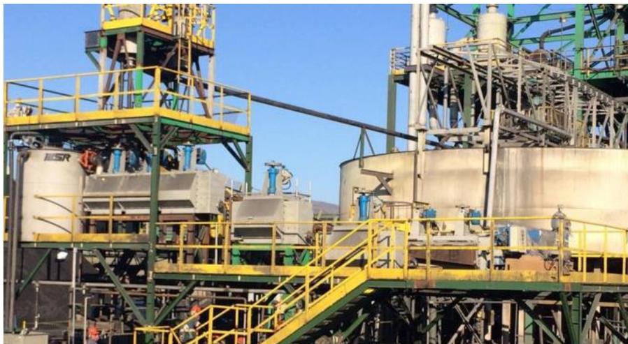
Figura 3.9 - Planta de flotação semi-industrial da Vanádio de Maracás.
