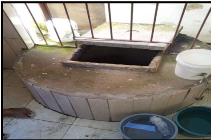
Figura 01. Poço raso utilizado para fins de consumo humano
