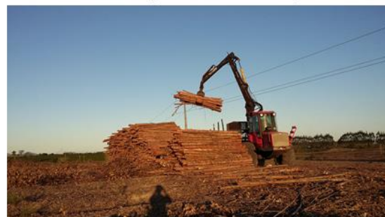
d. Extração e empilhamento de madeira. Foto: Própria.
