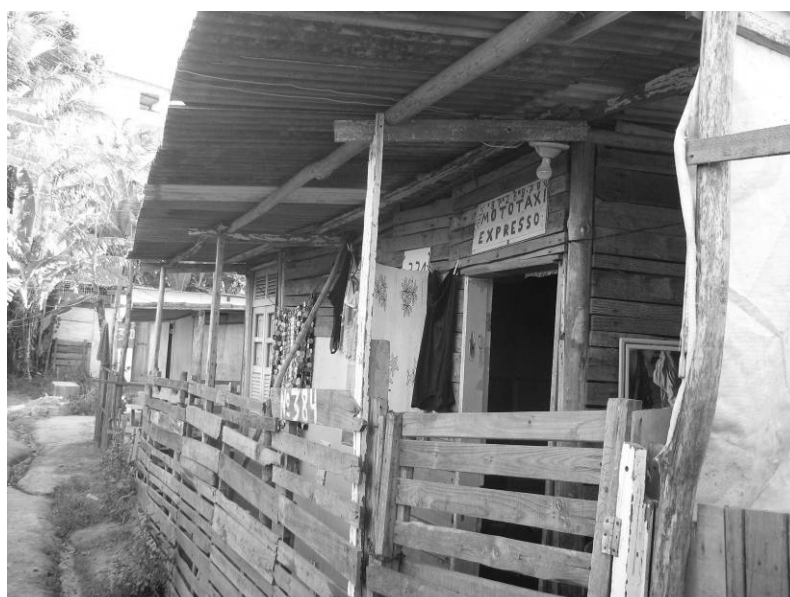
Barracos localizados na região traseira da ocupação de Escada
