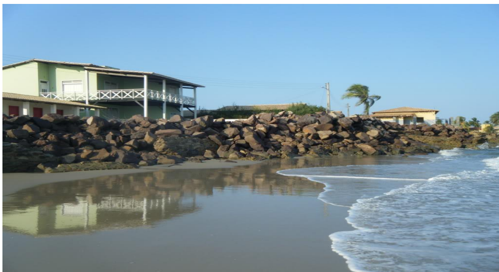
Imagem 7: Praia do Saco: Enrocamentos construídos para tentar salvar as casa do avanço do mar. Fonte: http://www.skyscrapercity.com/showthread.php?t=368188&page=9 http://www.skyscraper city.com/showthread.php?t=368188&page=9
