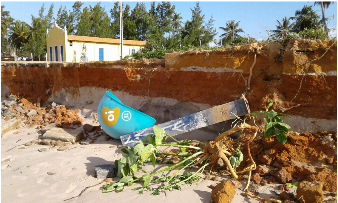
Imagem 4: Igreja na praia do saco comprometida após o avanço do mar
