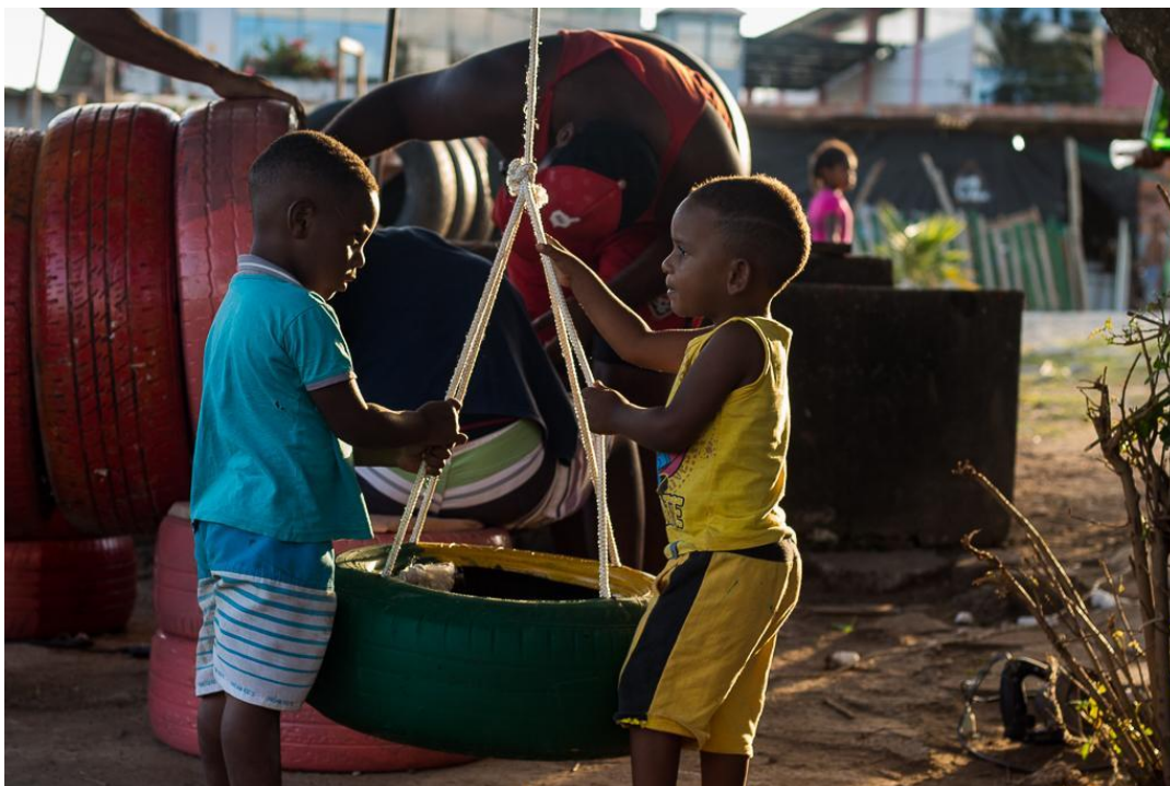
Figura 38 - Construção do Mão na Massa
