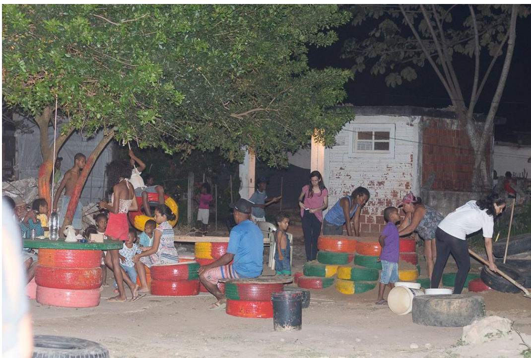
Figura 39 - Finalização da construção Mão na Massa
