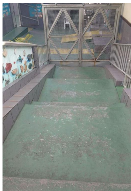
ESCADA DE ACESSO À ESCOLA
