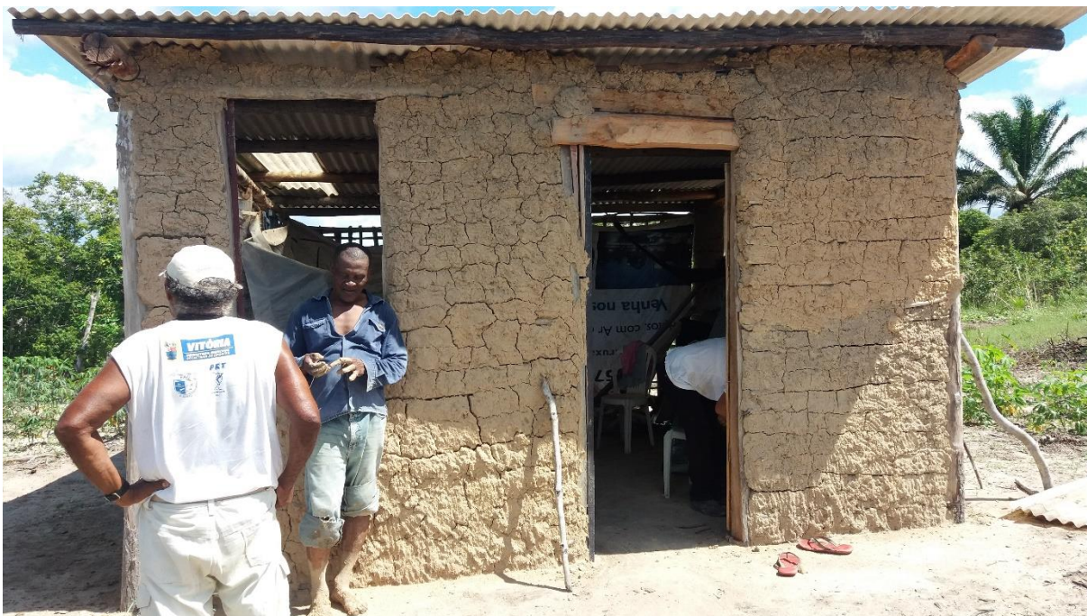
Figura 5: Foto da casa construída por sr. Toninho (camisa azul), tirada durante o circuito pela aldeia Cahy com o cacique Timborana (de costas na foto). Encontramos o senhor Toninho amassando o barro para rebocar a amarração de madeira
