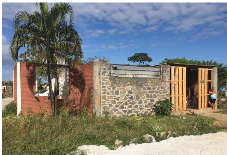
Figura 12 :Situação do Casarão na primeira visita da RAU+E à Ocupação
