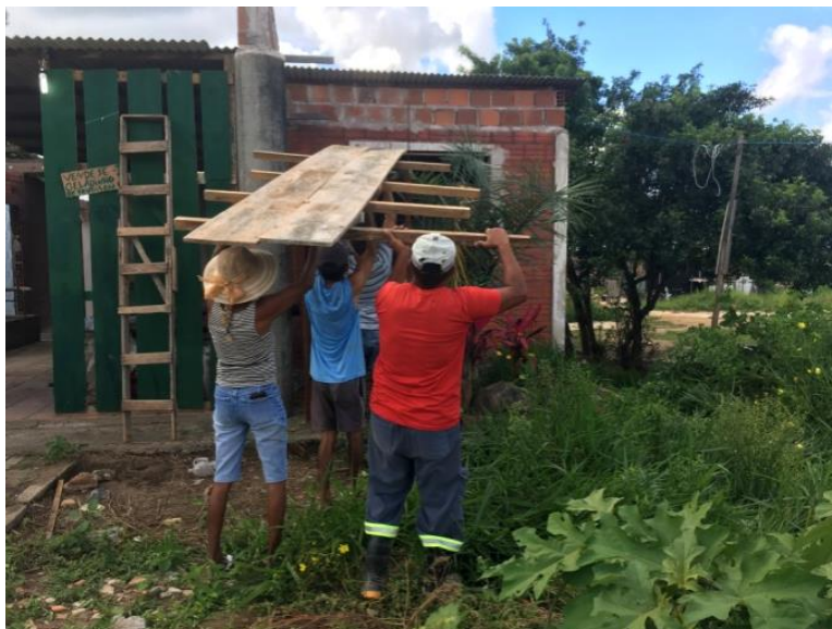
Figura 40 :Mutirão para cobertura do Casarão
