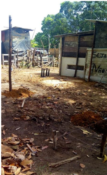
Fotos 66 e 67: Marcação das medidas para construção da cozinha
