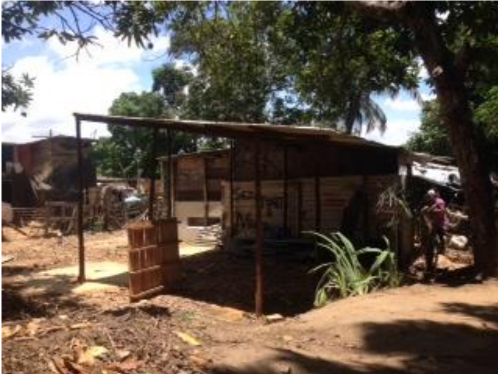
Foto 68: Estrutura da cozinha construída
