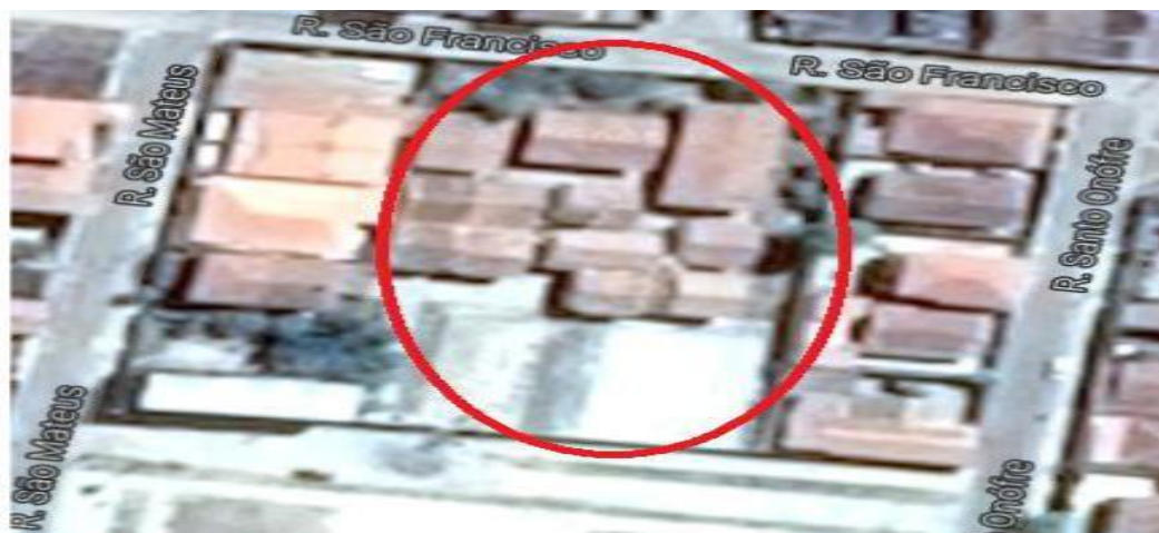
Figura 8: Vista aérea da Escola M. Tenente Wilson
