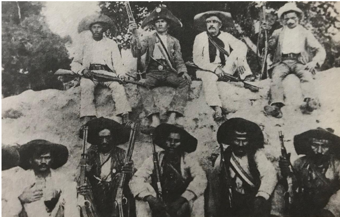
Imagem 8: Sediciosos reunidos na trincheira construída ao redor da cidade de Juazeiro. Em cima, o terceiro da esquerda para direita, é Floro Bartolomeu.
