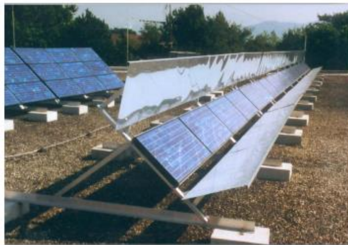
Figura 5 - Módulos FV com concentradores com baixo fator de concentração Fonte: HOFFMAN, 2005
