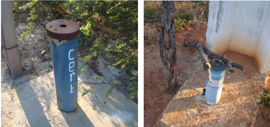
Figura 3: Poços lacrados no município de Lagoa Real nas localidades de Barbeiro e Brejal, respectivamente.
