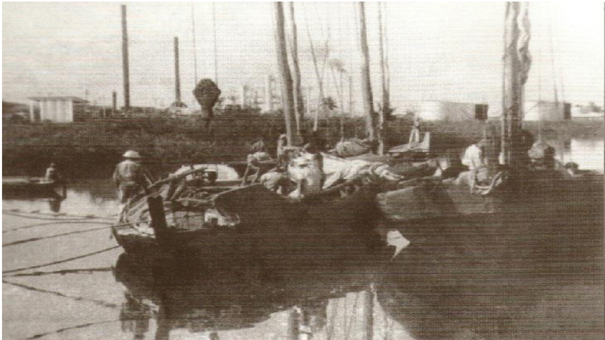
Figura 08: Imagem dos equipamentos para a construção da refinaria sendo transportados pelos saveiros, que chegavam através da Baía de Todos os Santos. Ao fundo da foto podemos ver os tanques de petróleo.
