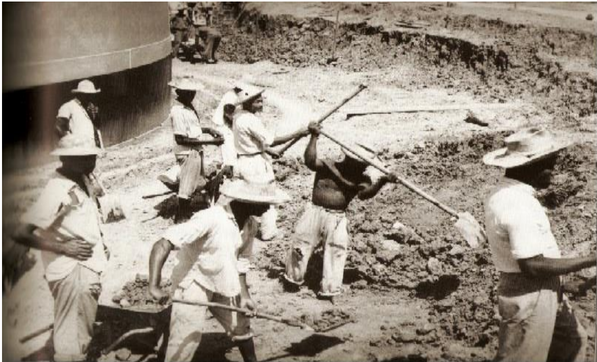
Figura 09 – Imagem de Homens trabalhando nos tanques de armazenamento na Refinaria.
