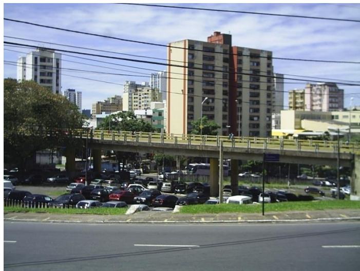
Fig. 47. Estacionamento São Raimundo e viaduto da Piedade, desde a perspectiva dos espectadores convidados.
