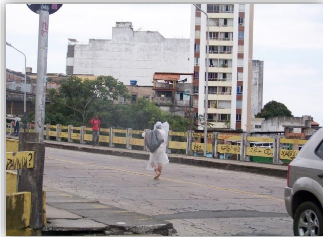
Fig. 9. Despojado no meio do viaduto.
