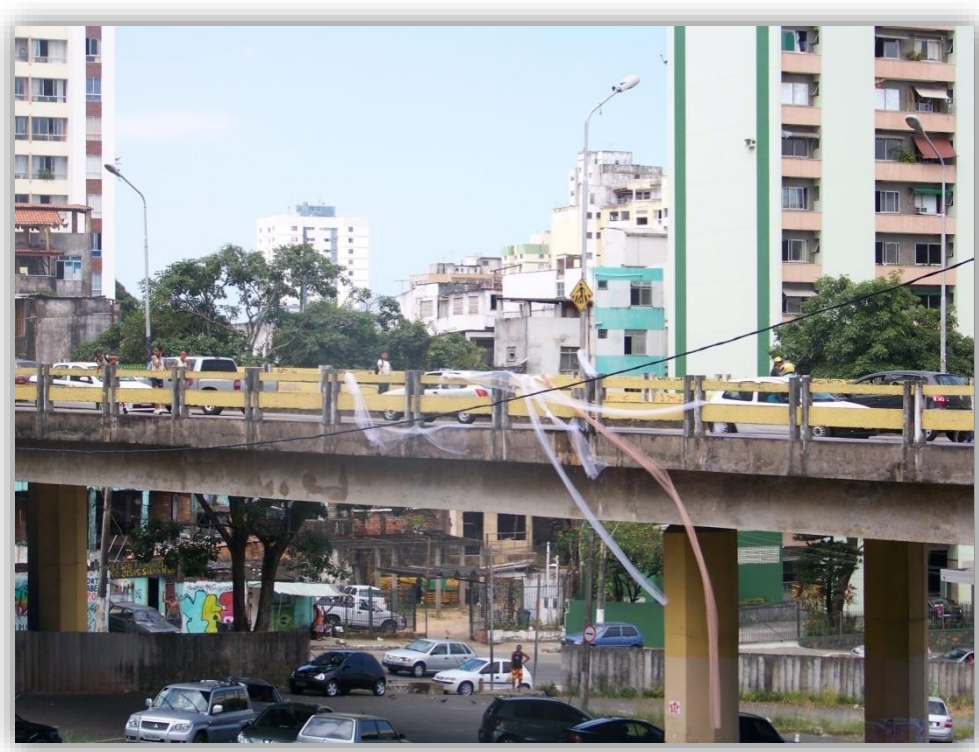
Fig. 62. Instalação/apropriação “Filós ao Vento”.
