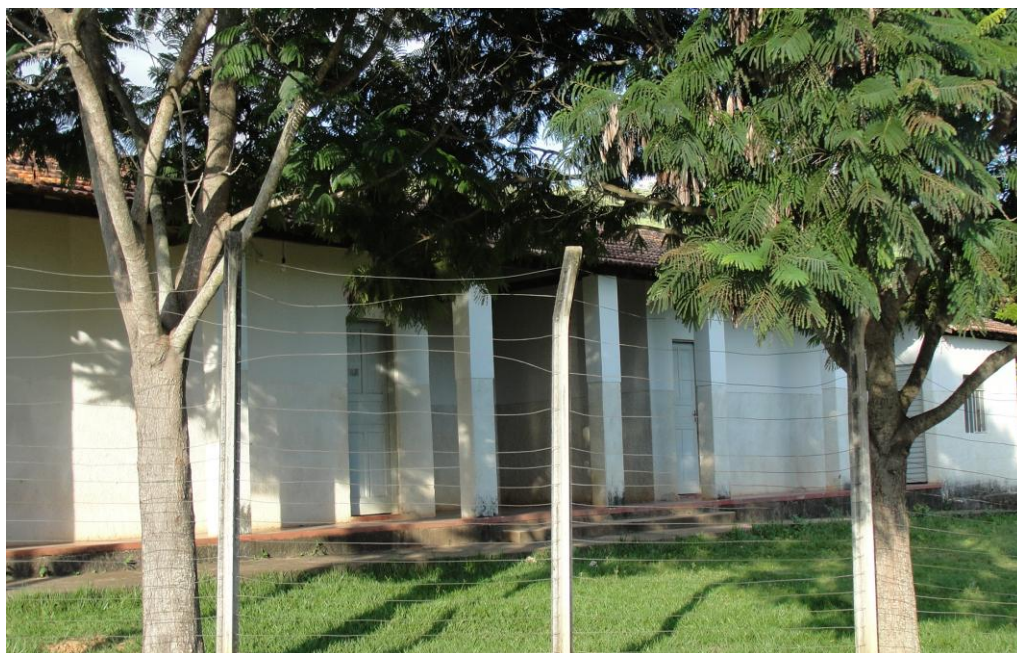
Fig.4 – Prédio atual da escola - Morro Alto
