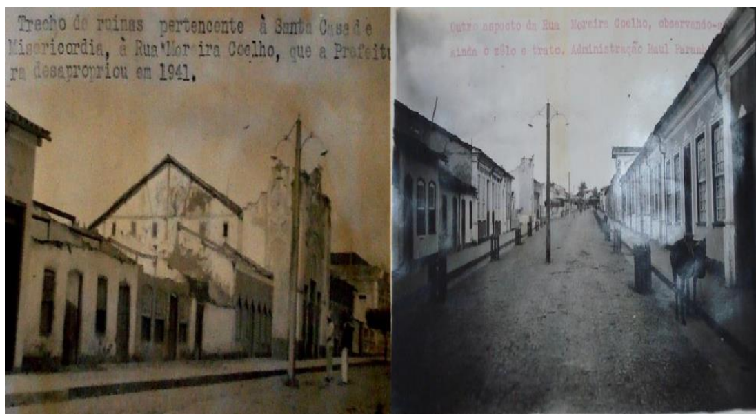
Figura 13 - Trecho da Rua Moreira Coelho com prédios em ruínas pertencentes à Santa Casa de Misericórdia e a mesma após seu alinhamento e alargamento na gestão de Raul Paranhos
