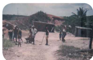
Mutirão para implantação de rede alternativa de abastecimento de água
