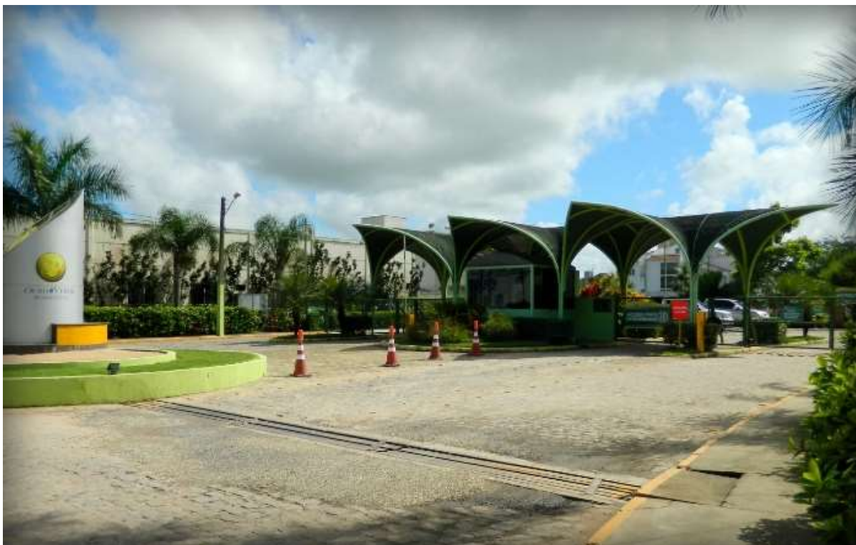
Figura 2. Residencial Ouro Verde, condomínio de Alto Padrão. Fonte: Acervo pessoal. Arapiraca, 2017.
