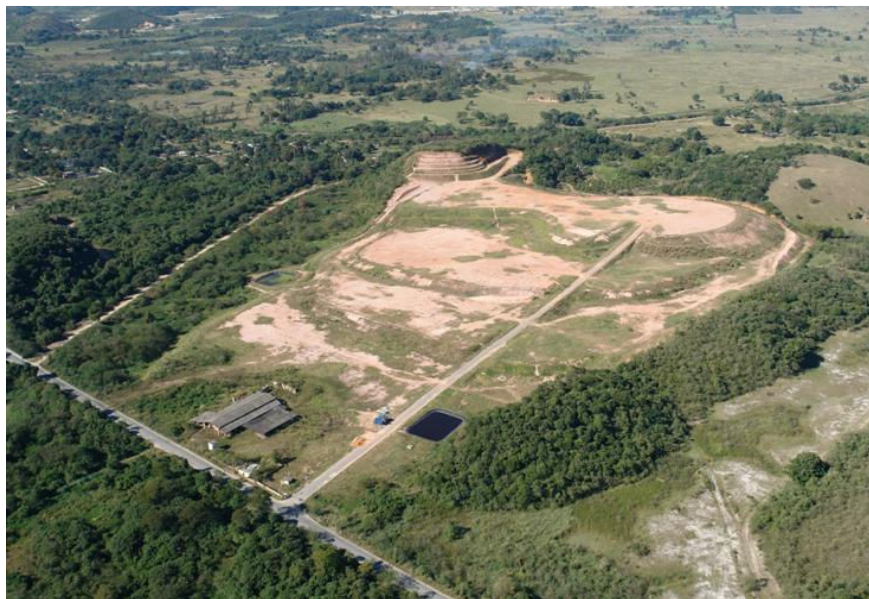
Figura 43 – Lixão de Marambaia após fechamento e remediação ambiental
