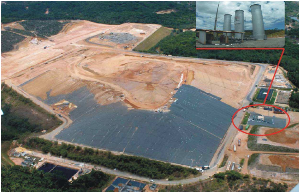
Figura 41 – Disposição dos flares no Aterro Sanitário de Salvador Fonte: Rothballer (2008)
