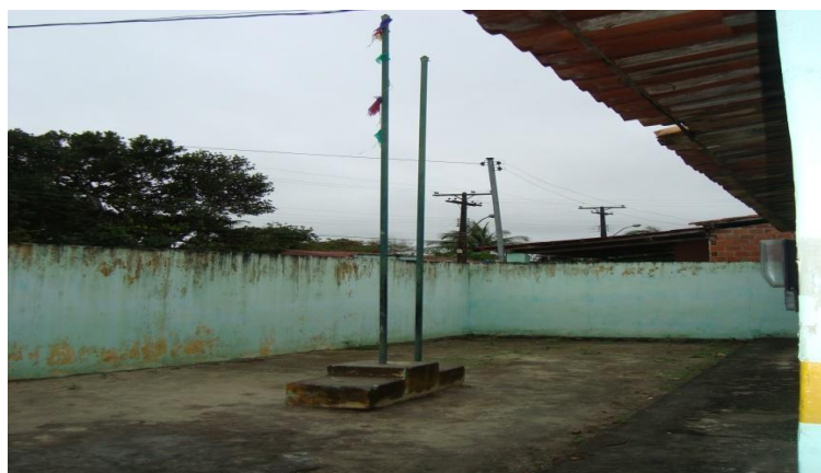
Fotografia 28. Área externa da escola com o mastro para hastear bandeira - Arquivo pessoal da pesquisadora
