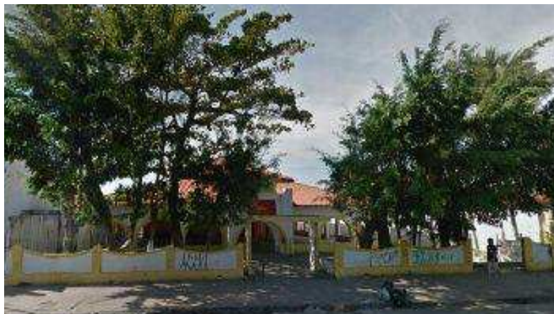
Fotografia: Google Street View
