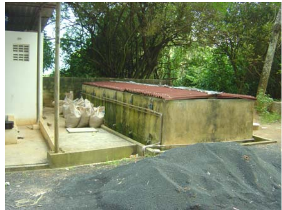
Vista das câmaras dos doze filtros cobertas com telhas.
