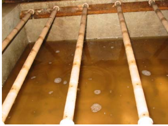
Vista de um filtro colmatado com a camada de esgoto empoadada.
