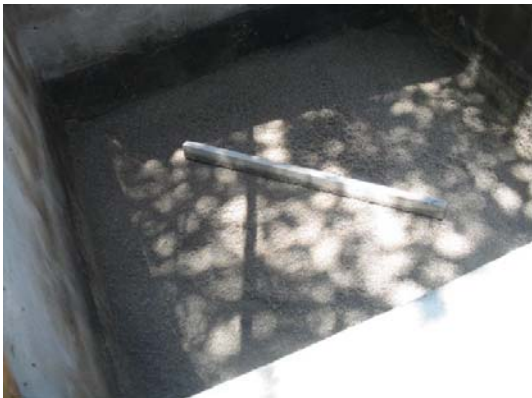
Vista após a retirada de 10 cm de areia do filtro.
