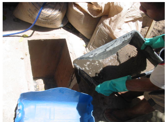
Após a lavagem, a retirada do líquido com o lodo gerado.
