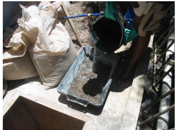
Operador jogando água na areia retirada para lavagem.
