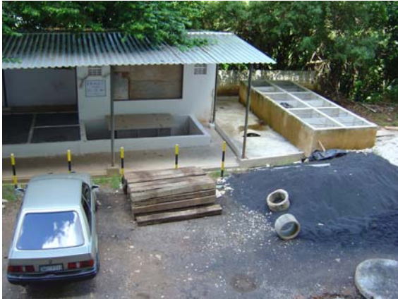
Vista da esquerda para a direita dos decantadores, do CBR e dos filtros.
