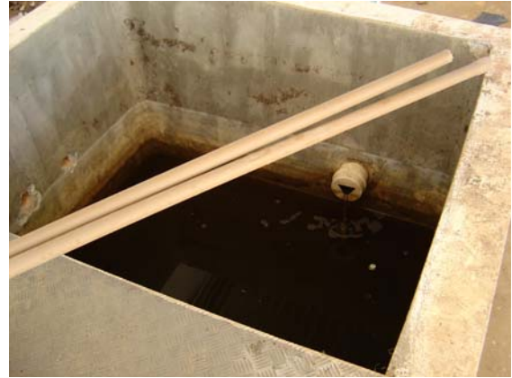
Vista do interior do tanque do afluente dos filtros onde as bombas foram instaladas.
