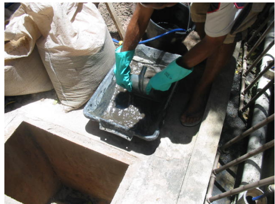
Operador lavando a areia retirada com lodo.
