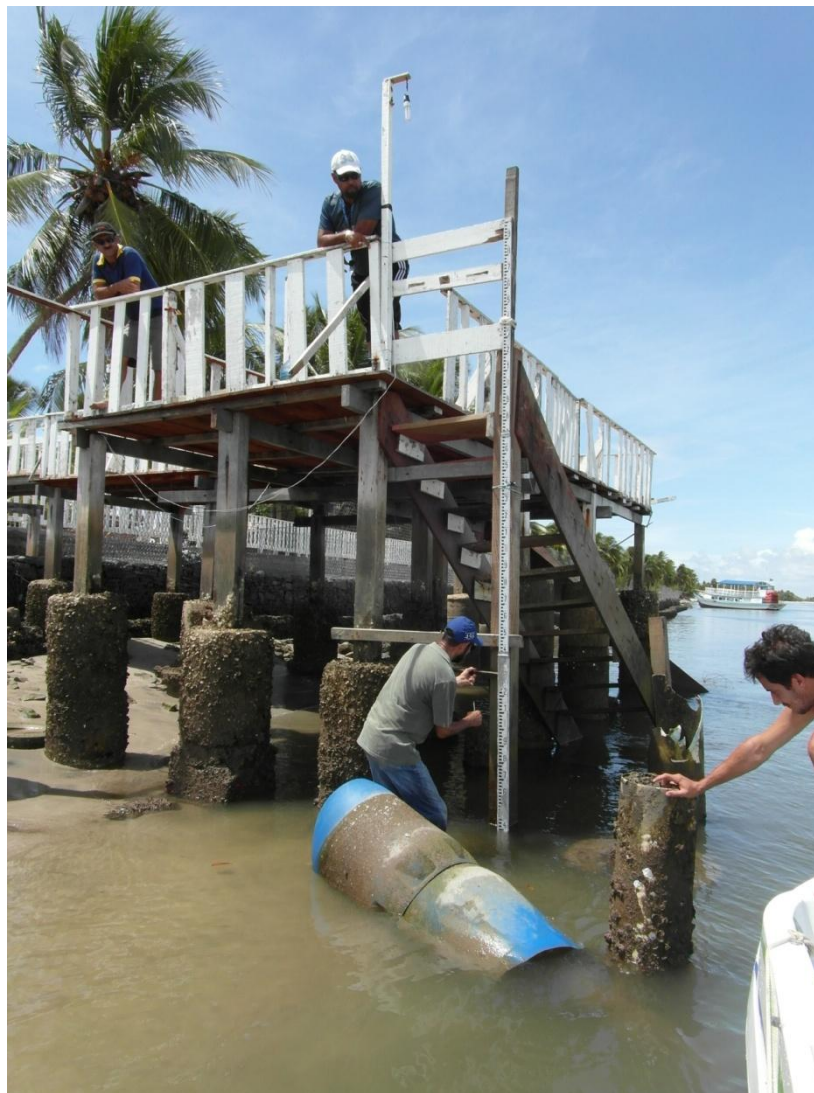
Figura 18- Régua instalada para verificação do nível das marés nos estuários
